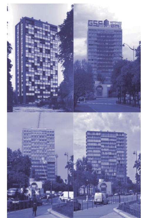
Fig.3 - Transformation of Bois le Prêtre (exterior). © Druot, Lacaton & Vassal.
